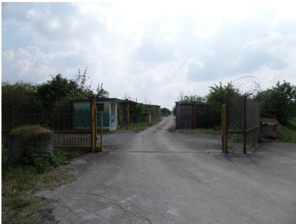
Fig. 1 - Entrata dell'ex zona di lancio della Nato di Ceggia.
